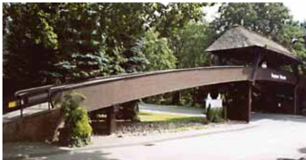
Bild 6b Fußgänger- und Radwegbrücke Walsrode (1972)
