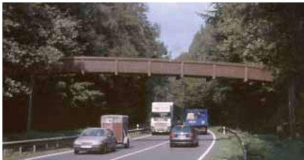
Bild 6a Fußgänger- und Radwegbrücke Münster (1962)
