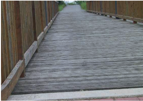
Bohlenbelag in gepflegtem Zustand. Keine Verschmutzung, Vermossung, Veralgung erkennbar.
