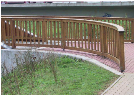
Geländer weist keine mutwilligen Beschädigungen auf.
