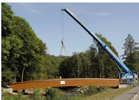
Einhub der vorgefertigten Brücke
