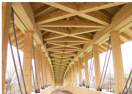
Innenansicht der Fachwerkbrücke
