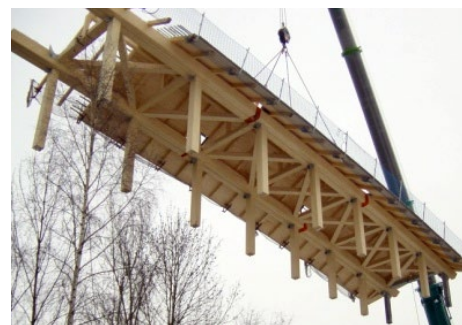
Montage des Fachwerkdaches mithilfe eines Schwerlastkranes. Aufgrund der großen Spannweite wurde das Dach in drei Einzelteilen montiert.
