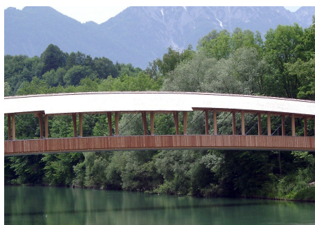
Ansicht auf die Fachwerkbrücke
