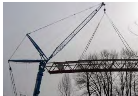
Montage des Fachwerkes mithilfe eines Schwerlastkranes.
