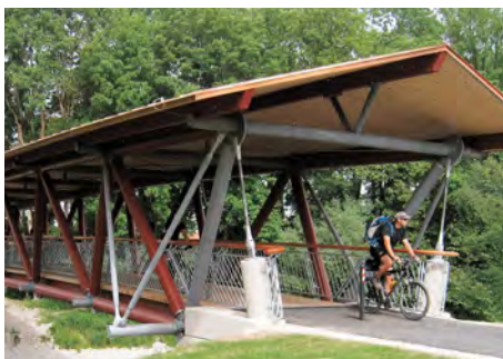
Ansicht auf Bohlenbelag aus Holz, Geländer und BSH-Rundhölzer des Fachwerkes
