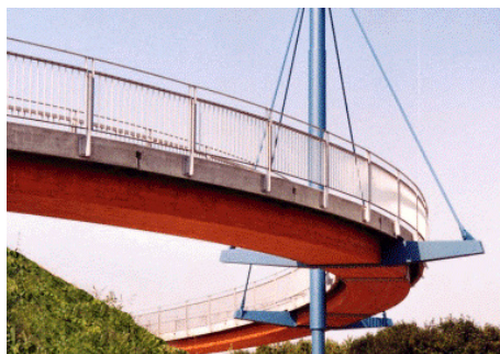
Geländer, blockverleimter BSH-Träger und blauer Pylon sind gut zu erkennen
