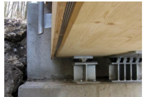
Ansicht auf Widerlager
