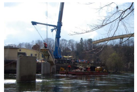
Montage des zweiten Teilstückes
