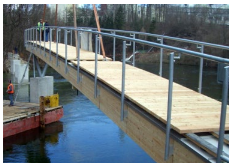
Montage des Anfangsstückes der Brücke
