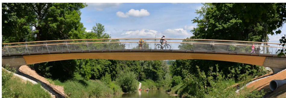
Fuß- /Radwegbrücke „Birkelspitze“ Weinstadt nach dem Konzept der Stuttgarter Holzbrücke
