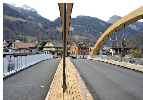
Ansicht Gehweg und Fahrbahn
