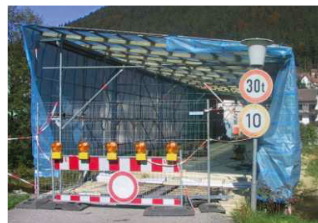
Zustand während der Bauarbeiten
