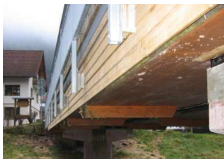
Ansicht auf die Unterseite mit hinterlüfteter Holzverschalung und BSH-Träger
