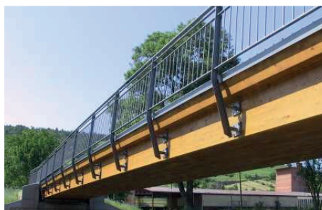
Witterungsschutz durch großen Überstand
