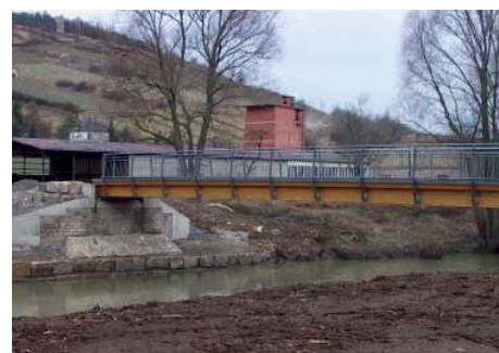
Seitenansicht kurz nach Fertigstellung
