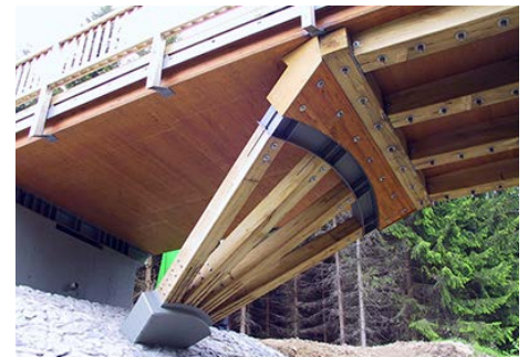
Sprengwerk und Geländer aus Eichenvollholz
