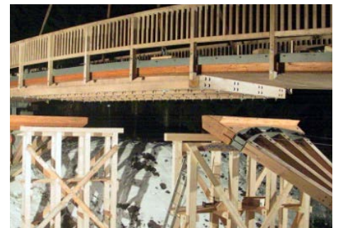
Montage: der blockverleimte Holzträger wird auf die beiden Streben des Sprengwerkes gesetzt.
