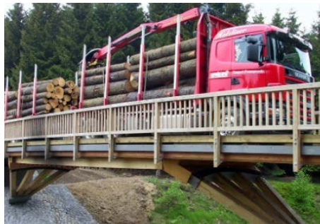
Ansicht auf die Sprengwerkbrücke
