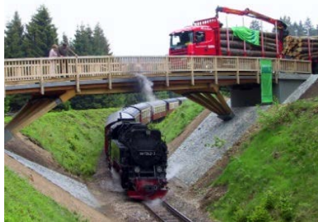
Überstehender Fahrbahnbelag bietet Witterungsschutz
