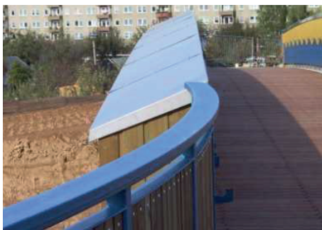
Witterungsschutz durch oberseitige Bleche
