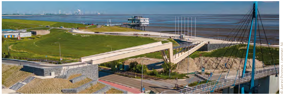
Markante Trogbrücke aus Brett-schichtholz mit außergewöhnlichem Tragwerk in Z-Form
