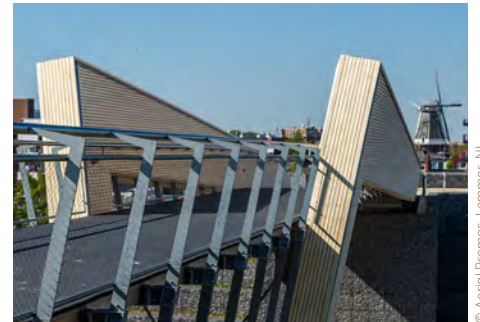
Ansicht der konisch laufenden Hauptträger
