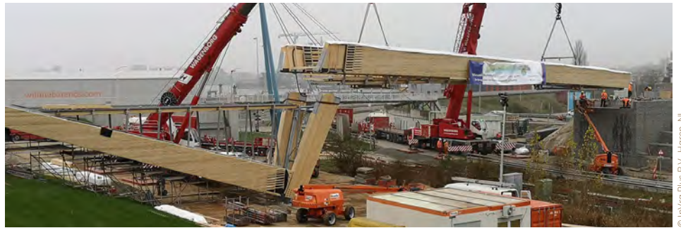
Montage der zweifeldrigen Trogbrücke in Delfzijl
