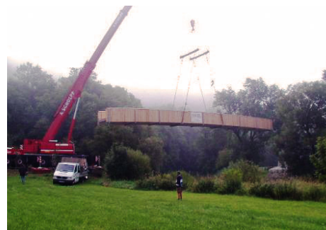
Montage mithilfe eines Schwerlastkrans
