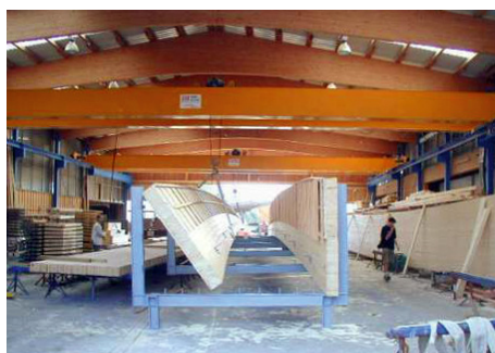
Vorfertigung der Brücke im Werk
