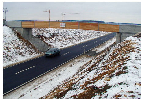
Ansicht auf Trogbrücke aus BSH
