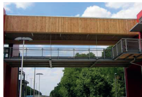
Ansicht Mittelteil mit Holzverschalung
