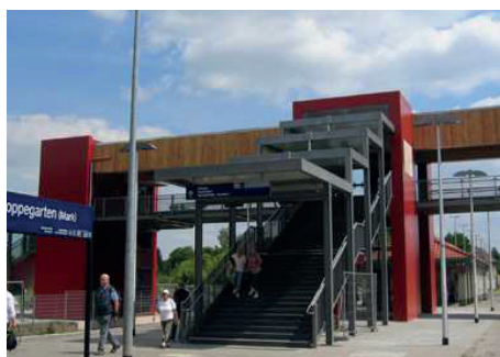
Ansicht Aufgang und linker Teil mit abgehangener Stahlfahrbahn
