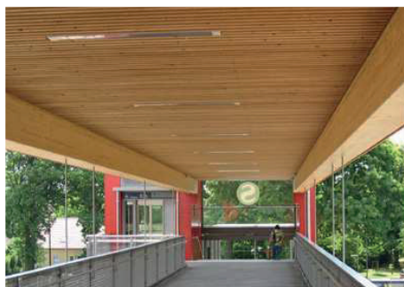
Abgehangene Decke mit integrierten Versorgungsleitungen
