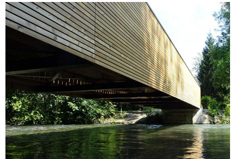
Witterungsschutz des Tragwerks aus Brettschichtholz durch eine Lärchenholzverkleidung
