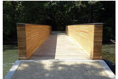
Die neue Brücke bietet Platz für Fußgänger und Radfahrer
