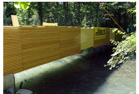
...Montage der Brücke erfolgten in einem Stück.
