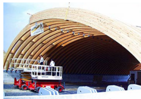
Montage der Bogenbinder
