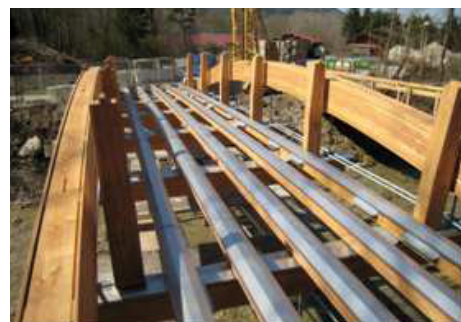
Während der Montage
