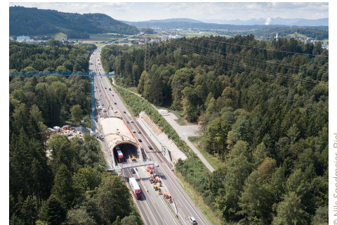
Luftbild während der Montage
