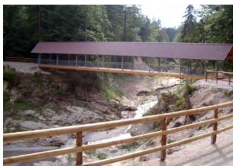
Ansicht auf die Fachwerkbrücke aus BSH
