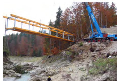
Montage des vorgefertigten Fachwerkträgers
