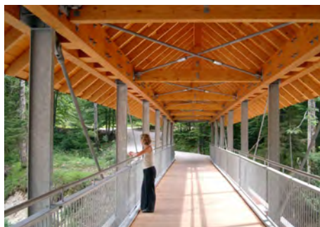
Abbildung zeigt das Stahlgeländer und den offenen Bohlenbelag
