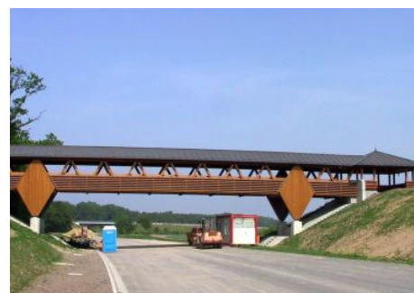
Ansicht auf die überdachte Fachwerkbrücke
