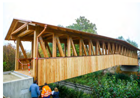
Arbeiten an der Brücke
