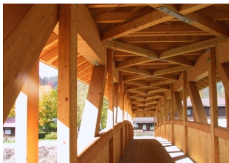
Innenansicht zeigt Holzgeländer, Bohlenbelag, sowie den hölzernen Aussteifungsverband
