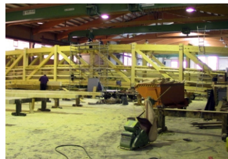
Ansicht auf die Vorfertigung des Fachwerkträgers im Werk.
