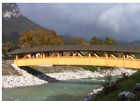
Ansicht auf die überdachte Fachwerkbrücke
