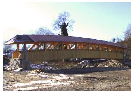
Fachwerkbrücke kurz nach der Montage
