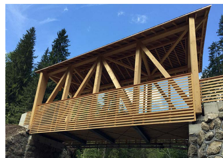
Die Holzbrücke ersetzt eine alte Betonbrücke
