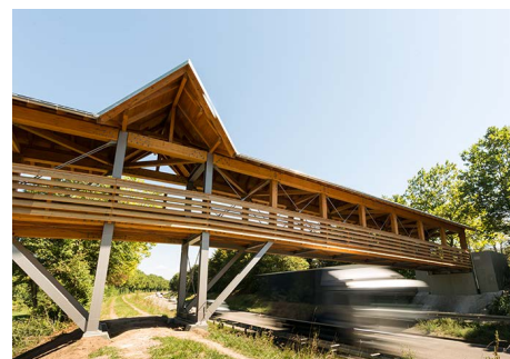
Brückensegment über B 317
