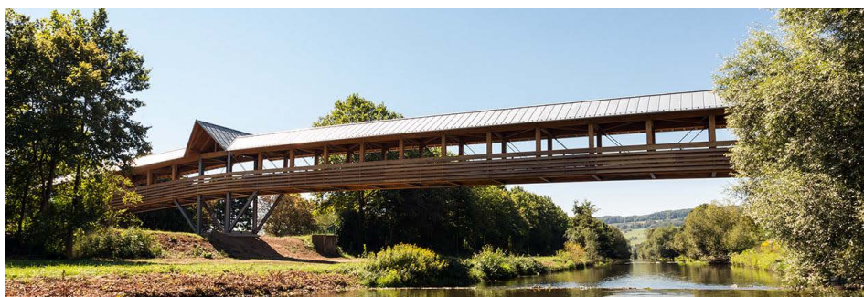
Brückensegment über die Wiese
