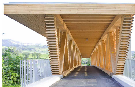
Frontansicht der Brücke
