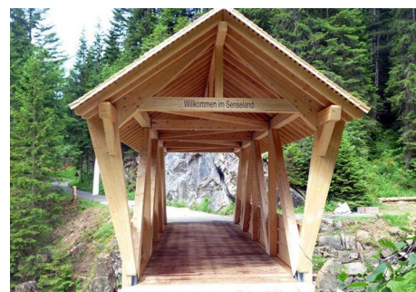
Ansicht Portal mit Dreigelenkrahmen
