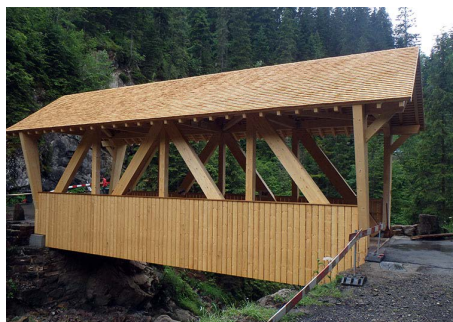
Holzschindeln schützen die Konstruktion vor Witterungseinflüssen
