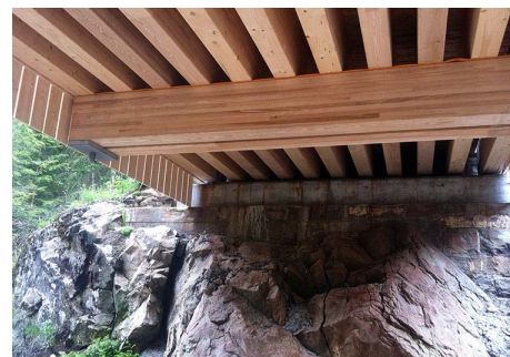
Fahrquerträger aus Eschen-Brettschichtholz
