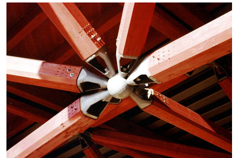
Raumknoten mit Stabköpfen aus Gussstahl, Kugelknoten geschmiedet mit Gewindebohrungen und hochfest vorgespannter Verschraubung
