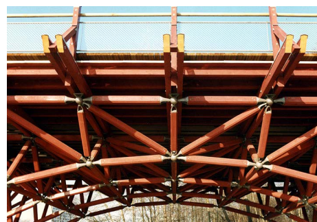
Seitenansicht, Raumfachwerk mit Deckaufbau
