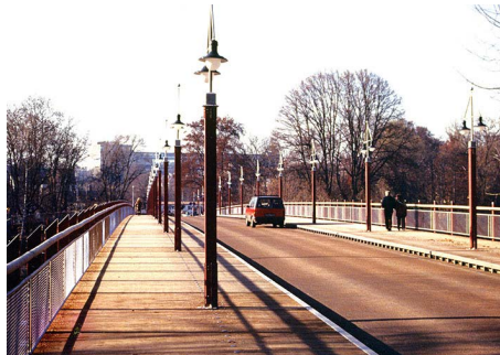
Blick auf die von Stahlborden und Entwässerungslinien eingefasste Fahrbahn mit breitem Geh- und Fahrradweg
