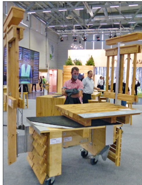
An der FH Aachen entwickeltes Modell einer geschützten Standardbrücke in Holzbauweise, das Anfang Juli auf der Messe „Dach und Holz“ in Köln gezeigt wurde. Rechts einige charakteristische Merkmale der Standardbrücke im Detail.
