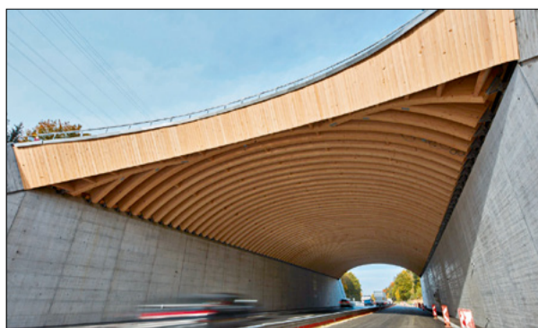
Untersicht der fertiggestellten Wildtierüberquerung Rynetel
