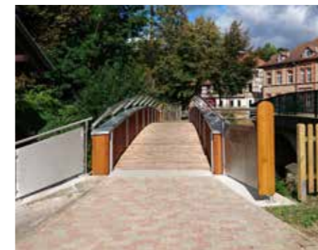
Foto: STAB Ingenieurbau Hermsdorf GmbH
