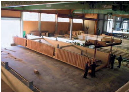
Vorfertigung einer Holzbrücke im Werk
