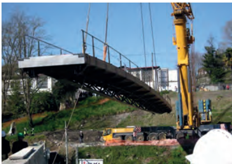
Montage einer Holzbrücke
