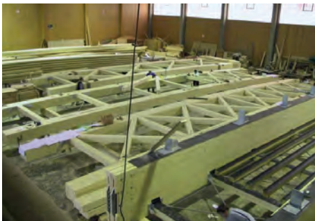
Werk-Fertigung von Bauteilen einer Holzbrücke
