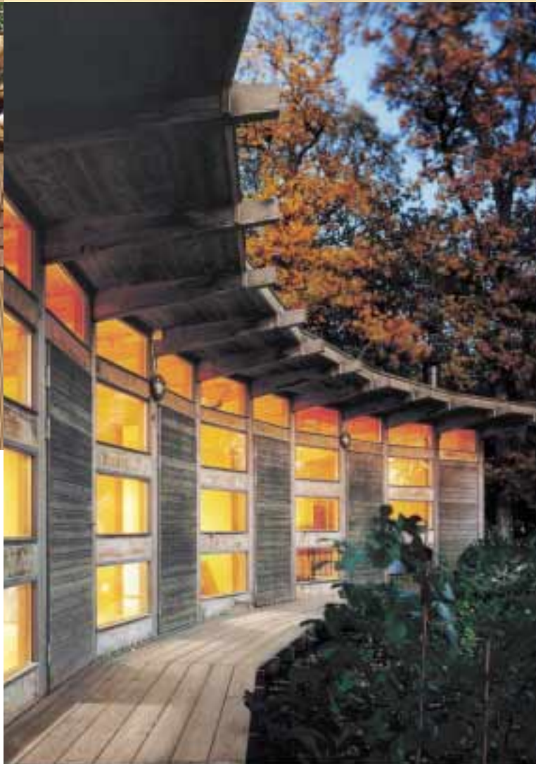
Abb. 31: Ebenerdiges, umlaufendes Deck an einem Sommerhaus
