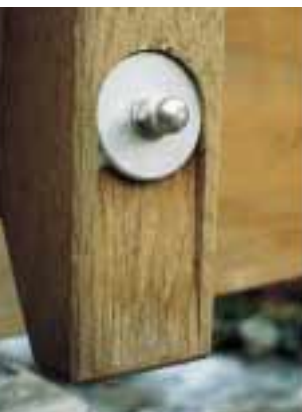
Abb. 5: Einlassen der Unterlegscheiben an einem Pfostenanschluss
