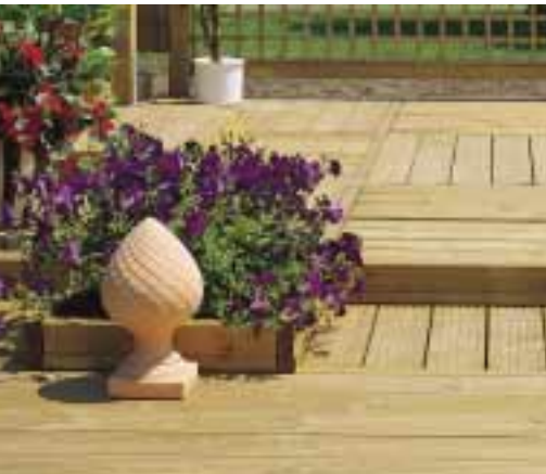
Abb. 28: Holzrost aus kesseldruckimprägnierter Kiefer
