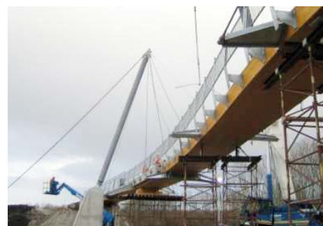
Ansicht während der Montage
