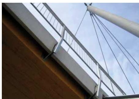
Ansicht Unterseite und Pylon rechts
