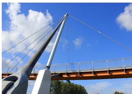
Bogen um Pylon
