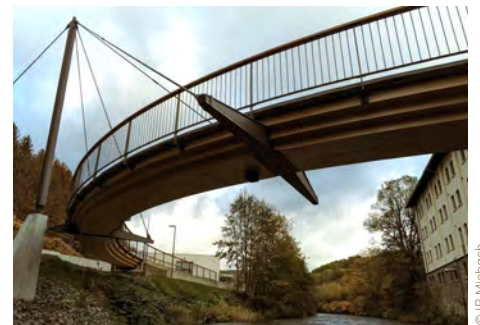
Untersicht der Brücke
