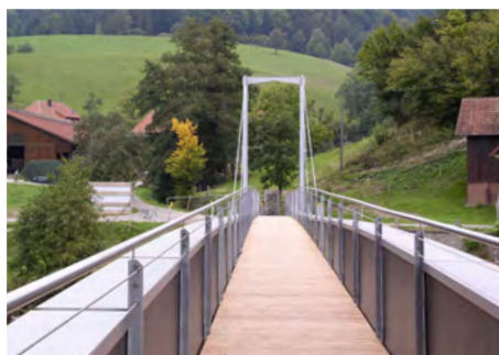
Ansicht Brücke mit Holzbohlenbelag in Lärche
