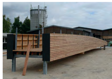
Vorgefertigtes Brückenteil mit Schalung, Belag und Geländerpfosten
