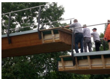
Montage des zweiten Teilstückes der Brücke
