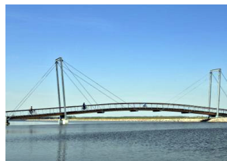
Ansicht auf die Pylonbrücke
