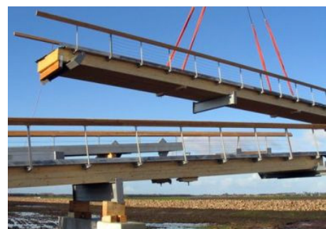
Montage des ersten Mittelstückes der Pylonbrücke
