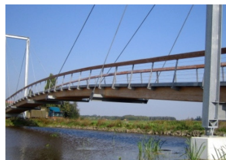
Stahlpylone und Stahlseile tragen den abgehängenen Fahrbahnbelag aus Gussasphalt.
