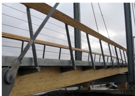
Ansicht Überstand Gussasphaltbelag und Blechabdeckung
