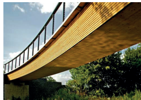
Geschwungener Brückenteil üb. Mühlgraben
