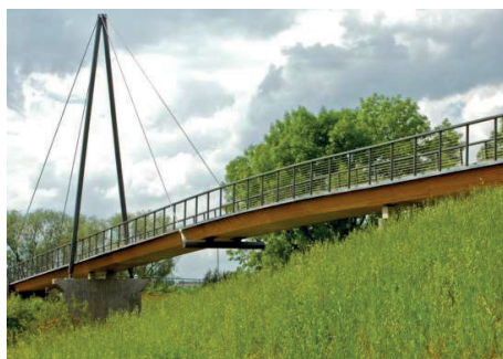
Ansicht Hauptbrückenteil ü. Lahn
