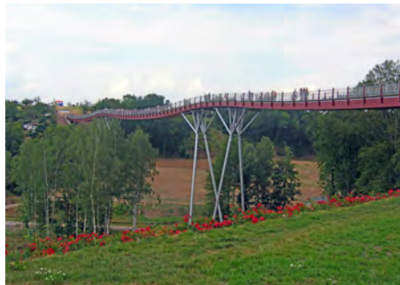
Seitenansicht auf die Spannbandbrücke
