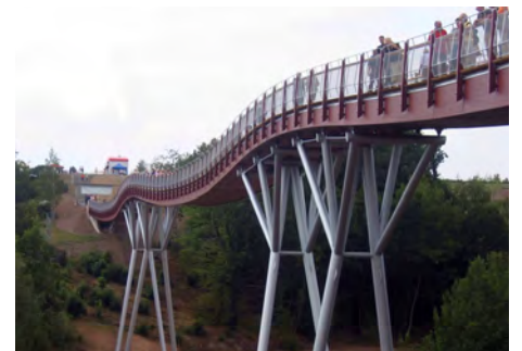
Kraftumlenkung an den Zwischenauflagern
