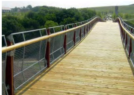
Bohlenbelag, Handlauf, Pfosten aus Lärche
