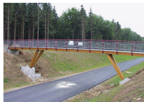
Ansicht auf die Sprengwerkbrücke aus BSH
