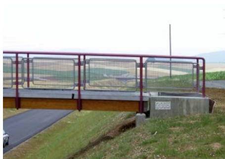
Ansicht auf das Widerlager
