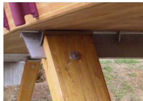
Detailansicht auf den Anschluss von Streben und Brückenplatte
