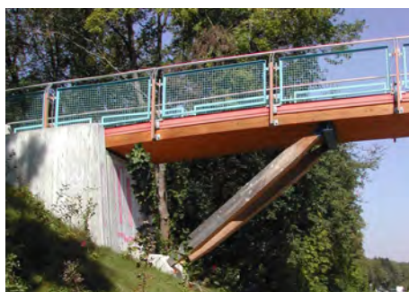
Ansicht Widerlager West
