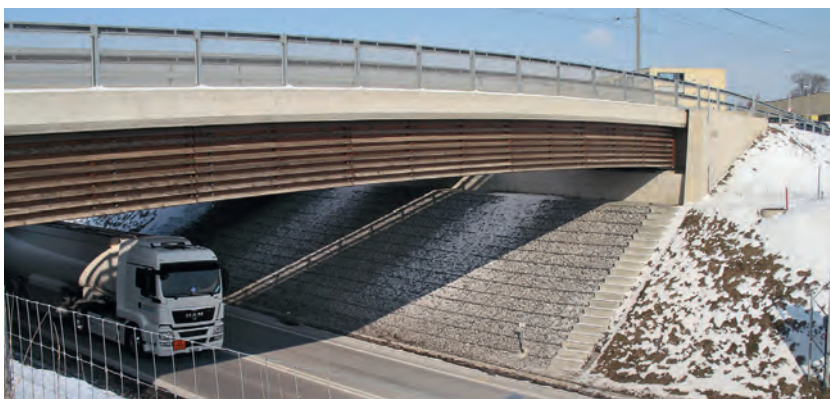
Abb.8: Umfahrung Bulle, Kanton Fribourg, 7 Holz-Beton-Verbundbrücken, Brücke Planchy erbaut 2005, Spannweite 33,5 m, 40 Tonnen, Entwurf: ASI, Association Sud Ingénieurs, Vial SA, Le Mouret, Bild: BFH
