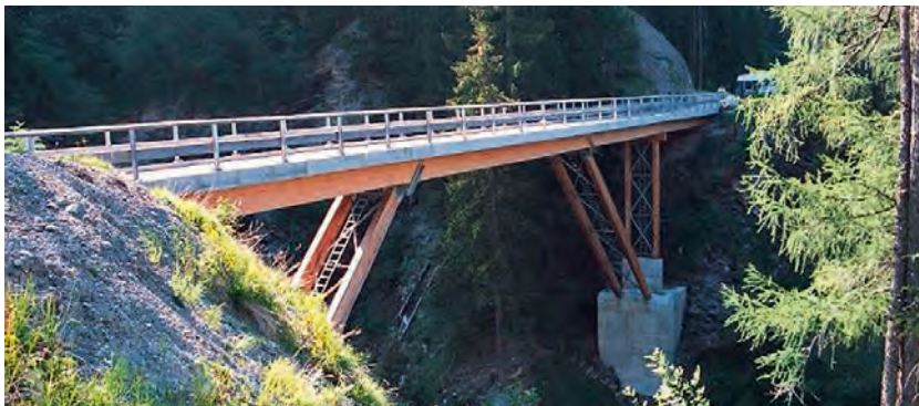
Abb. 7: Ronatobelbrücke in Fuma, Graubünden, Holz-Beton-Verbund, erbaut 1991; Spannweite 12-12,75-12,25 m; 28 Tonnen, Ingenieure Buchli + Joh. Fromm, Bild: Andrea Bernasconi HES-SO Yverdon/LIGNUM
