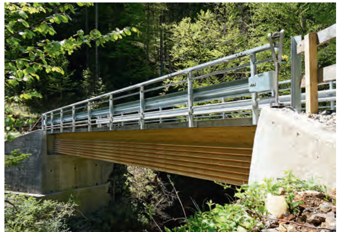
Abb. 9 + 10: Fruttlibrücke in Arth, Kanton Schwyz gebaut 2020, Spannweite: 10,45 m, 40 Tonnen, Holz- UHPC-Verbundkonstruktion, Entwurf: Edgar Kälin, Einsiedeln, Neue Holzbau AG, Lungern, Prof. E. Brühwiler EPFL Lausanne, Bilder: E. Kälin [4].
