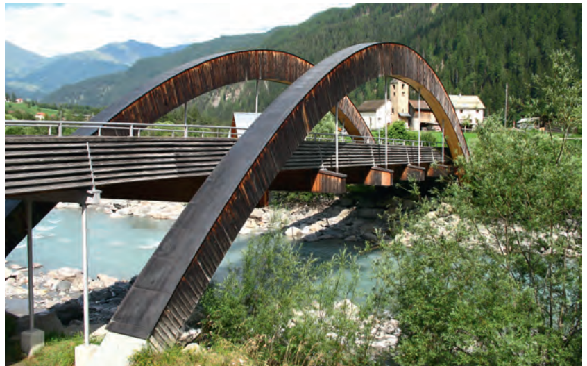
Abb. 3: Brücke San Nicla, Kanton Graubünden, gebaut 1993, Länge/ Spannweite: 47,8/39 m, Verkehrslast: 28 Tonnen, Typ: Bogenbrücke, Entwurf: A. Mayer, Sent, A. Deplazes, Chur, Prof. E. Gehri, Bilder: BFH
