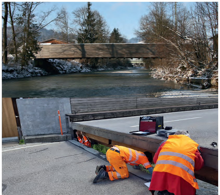
Abb. 4: Obermattbrücke, Kanton Bern, Baujahr 2007, bei Hochwasser höhenverstellbare (70 cm) Brücke, Spannweite: 32 m Nutzlast 40 Tonnen, Entwurf: Paul Grunder AG, Täufen, Bilder: BFH
