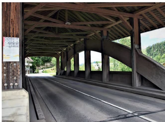
Abb. 1: «Dörfli-Brücke», Eggwil, Kanton Bern, gebaut 1985, Spannweite 30.6 m, Verkehrslast 28 Tonnen, Typ Gedeckte Bogenbrücke, Entwurf: H. Vogel und Prof. Gehri, ETH Zürich, Bilder: Doris de Marco Stalder.
