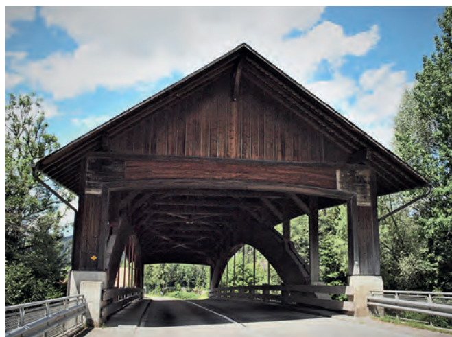
Abb. 2: «Bubenei-Brücke», Kanton Bern, gebaut 1988, Länge/Spannweite: 50.00/43,4 m, Verkehrslast 28 Tonnen, Typ Gedeckte Bogenbrücke, Entwurf: H. Vogel, Bern, Moor Hauser & Partner AG, Bern, Bilder: Doris de Marco Stalder.
