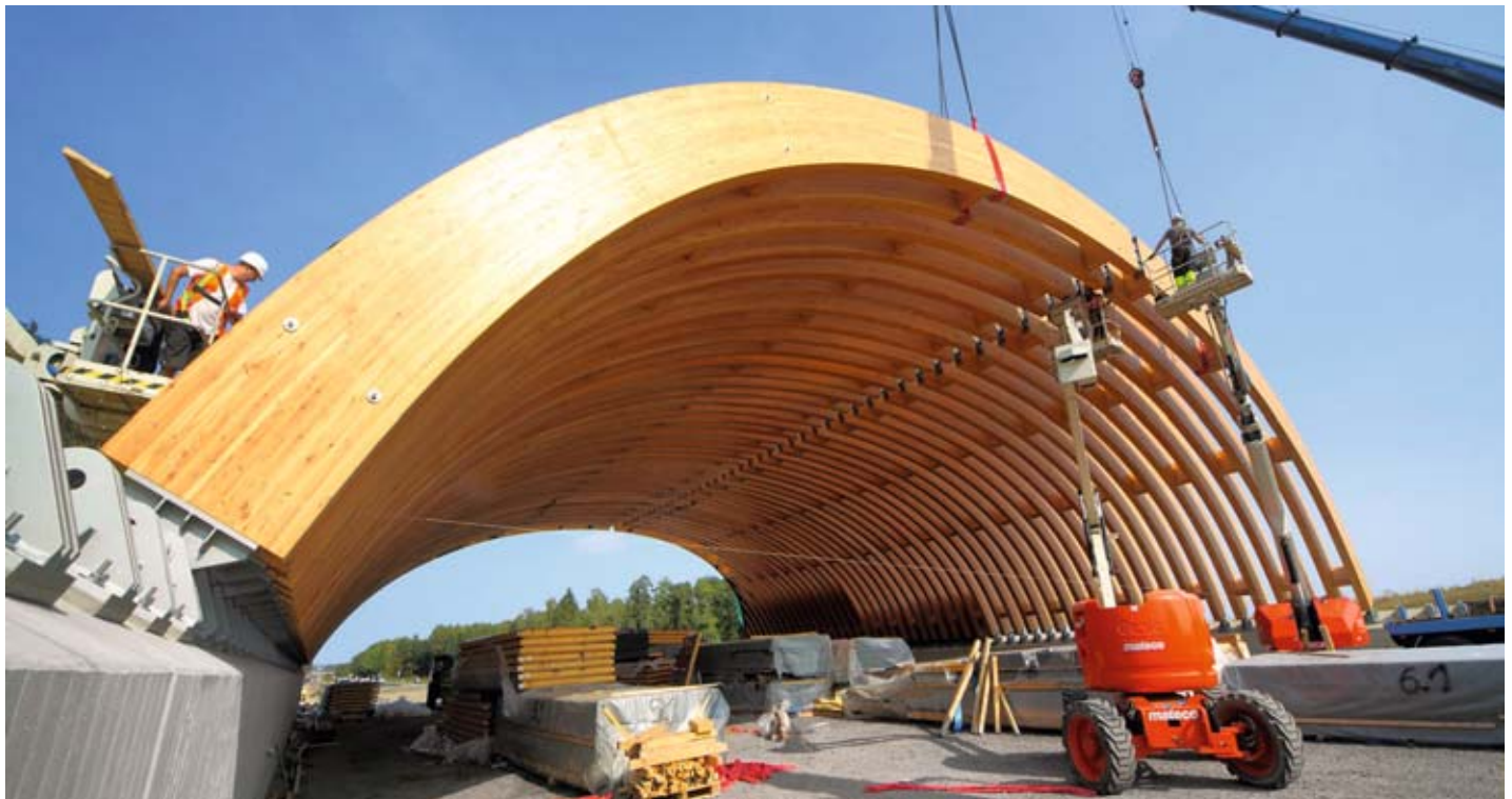
Eine Grünbrücke in der Bauphase.
